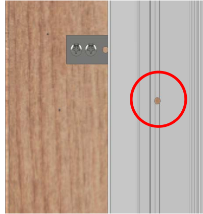
圖 14：露出外框立料固定導孔
